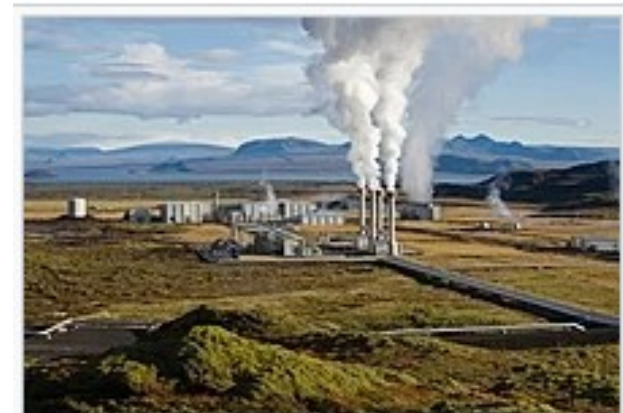
Centrale géothermique de Nesjavellir en Islande.
