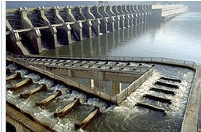
Échelle à poissons du Barrage John-Day sur le fleuve Columbia, aux États-Unis.
